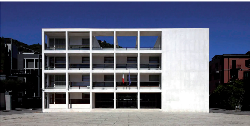
Como, Casa del fascio, Terragni
